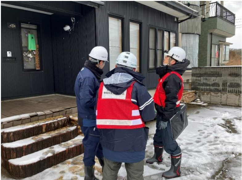
住家の被害認定調査（1/15～羽咋市内）
