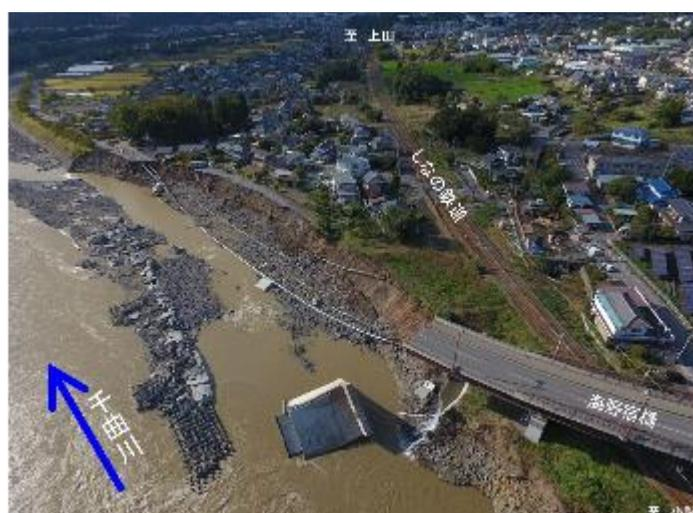
東日本台風による河川護岸の欠損と道路橋の損壊のため鉄道が運休
