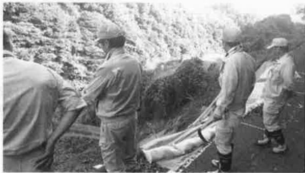
○災害箇所の確認
