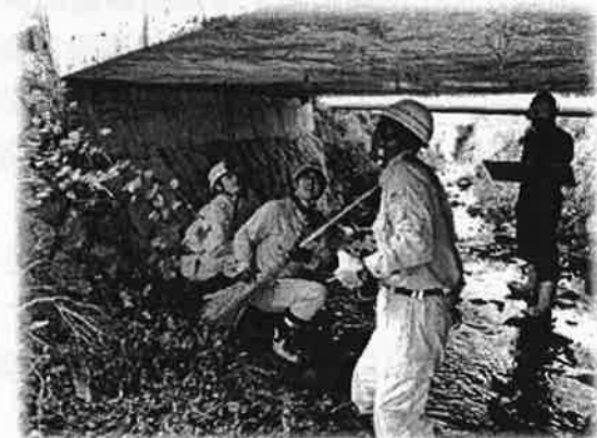
橋梁点検研修(国交省)受講して直営で点検(筑北村)
